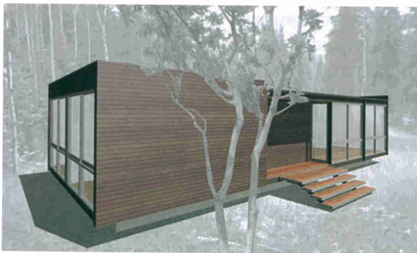
Un modèle de préfabriqué Marmol Radziner. Le revêtement peut-être en bois, métal ou verre et le client choisit le nombre des modules qui composeront sa maison. Marmol Radziner
