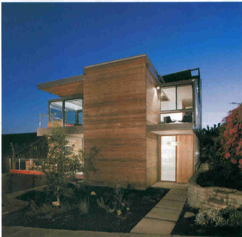
La maison verte de LivingHomes, préfabriquée, est installée en une journée. Son jardin est irrigué par des eaux usées grâce au système « greywater ». Tim Street-Porter
